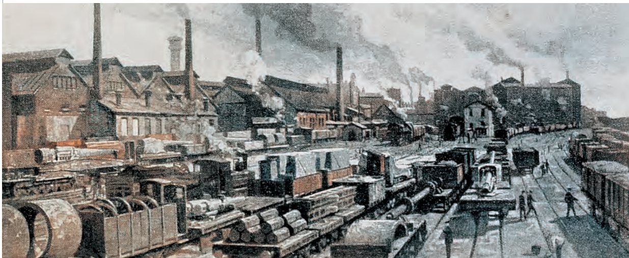
Anónimo (1914). Muelles centrales de la fábrica Krupp en Essen. En: Revista La Esfera , vol. 19. Madrid, España: Biblioteca Nacional. (Detalle).
