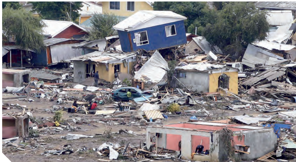
► Efectos en la costa de Iloca por el paso del tsunami de 2010.
