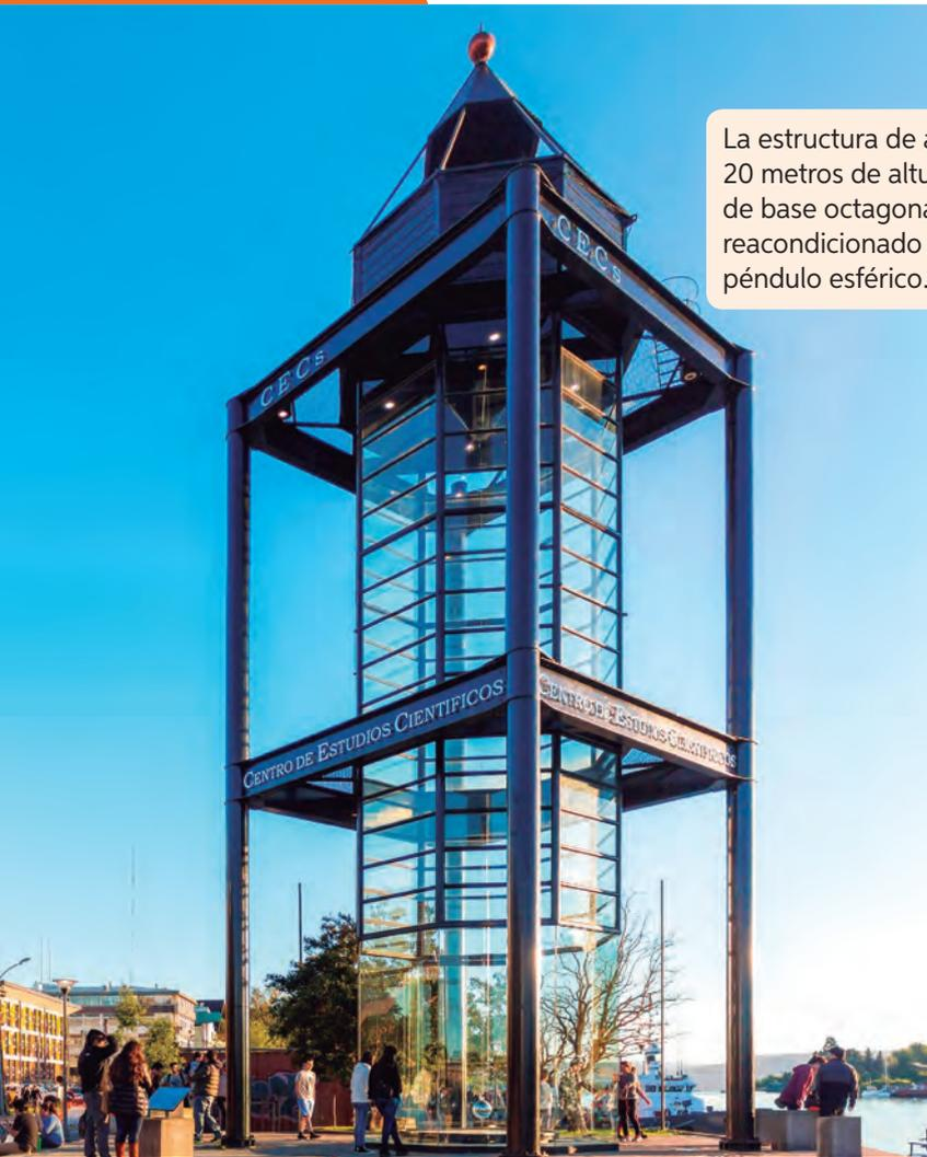
La estructura de acero tiene 20 metros de altura. La torre de base octagonal es un faro reacondicionado que sostiene el péndulo esférico.
